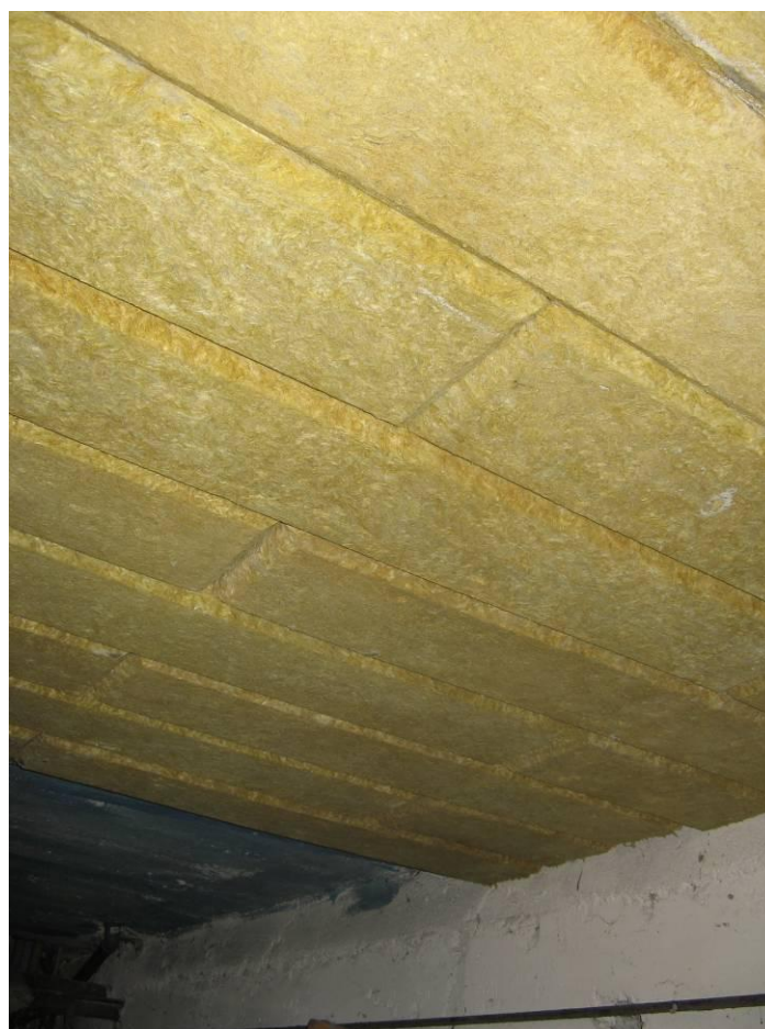
Fot. 4. Docieplanie stropu nad piwnicą
