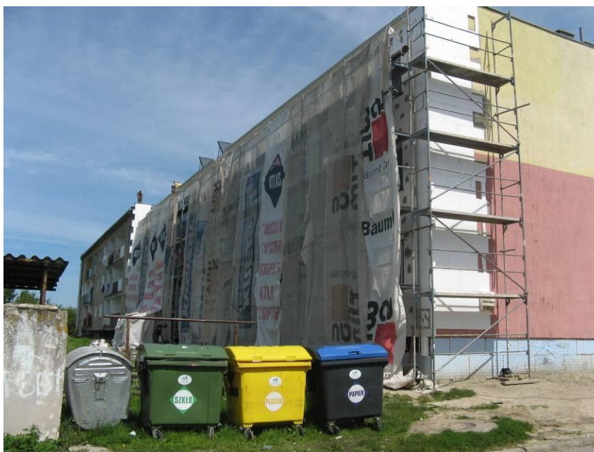
Fot.10. Docieplanie ścian, remont loggii.
