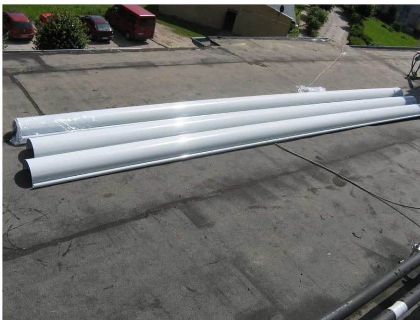
Fot. 8. Obróbki blacharskie dachowe
