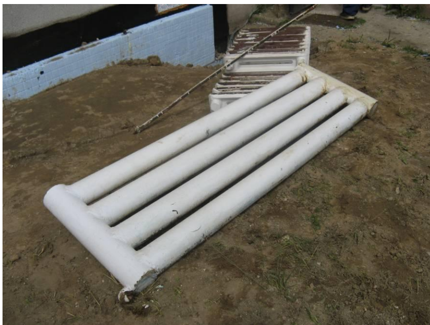
Fot. 6. Demontaż grzejników
