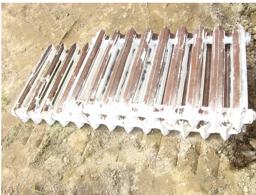
Fot. 2. Wymiana instalacji centralnego ogrzewania, demontaż grzejników
