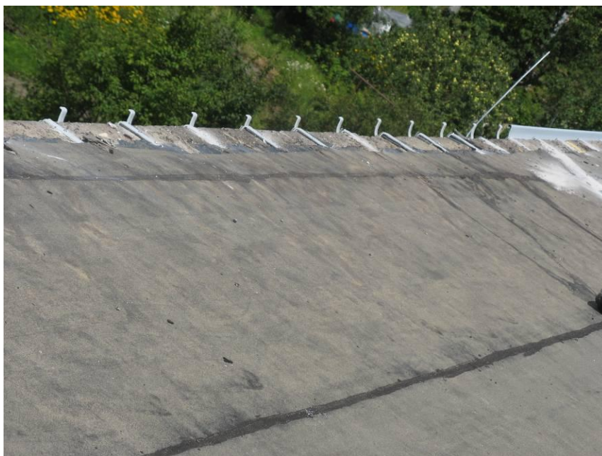
Fot. 7. Obróbki blacharskie dachowe
